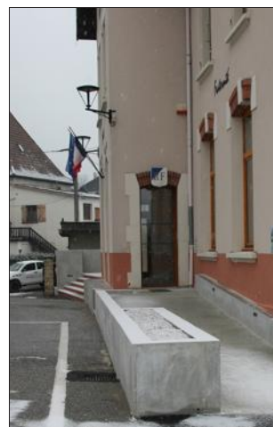
À gauche : la nouvelle rampe d'accès aux personnes à mobilité réduite. Photos de droite : à l'intérieur, l'escalier a été préservé et la salle des mariages a gagné en luminosité.
