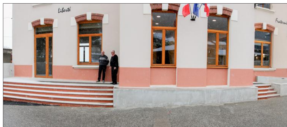
La nouvelle façade de la mairie, dotée d'un perron.
