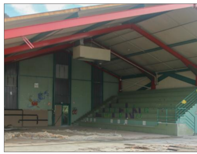
Les gradins seront supprimés et remplacés par des vestiaires et des sanitaires à niveau.
