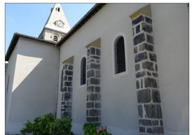
Les piliers aux pierres apparentes.
