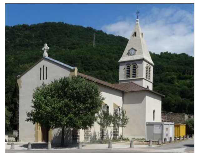
Le bâtiment complet.
