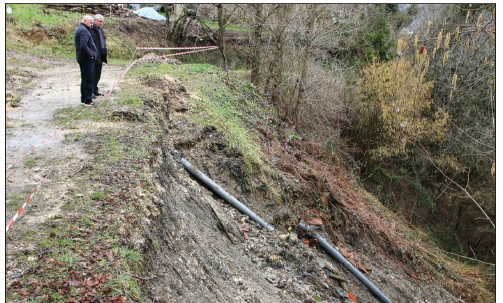
Le maire Gilbert Raymond et son adjoint Jean-Paul Brunet-Manquat constatent les dégâts. Un mois après le passage de la tempête Eleanor, la situation est loin d'être décaignée, surtout si les perturbations météorologiques persistent car de nombreux lieux de glissement de terrain ne sont pas stabilisés.
