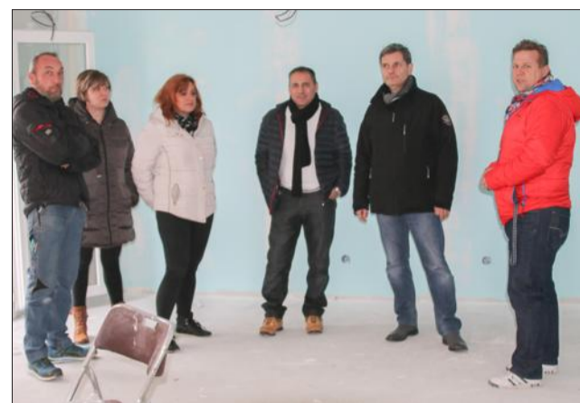
Visite du chantier par le maire, Claude Malia, accompagné de son adjoint aux travaux, Francis Martinez, en présence de techniques et du personnel de la mairie ainsi que l'un des entrepreneurs (à droite).
